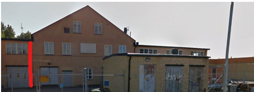
Figur 9: Bebyggelsen till höger om röd linje förses med rivningsförbud och skydds- och varsamhetsbestämmelser.
